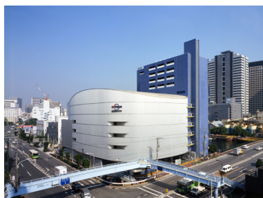
再生可能エネルギーに切り替えた天王洲スタジオ
